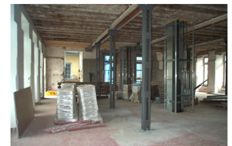
Bau Rohbau und Innenausbau in der alten Spinnerei I
