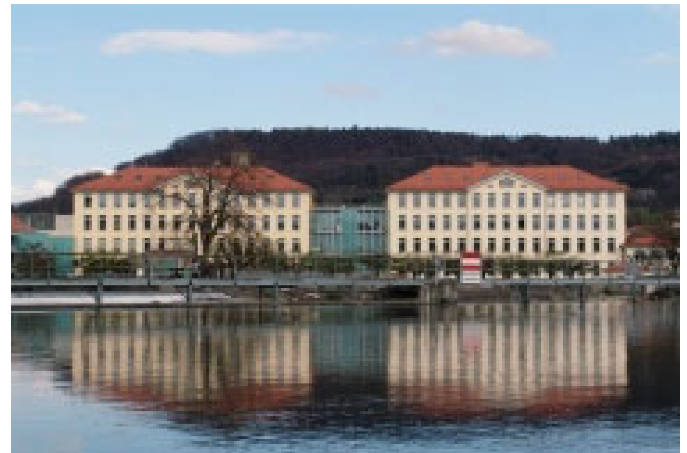
Markant die Gebäude der ehemaligen Spinnereien I und II
